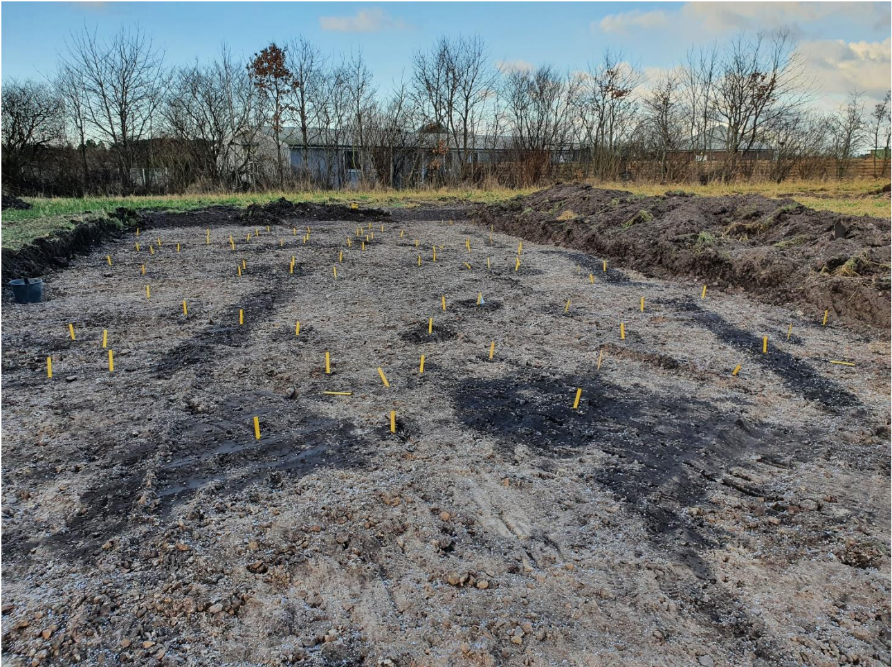
Figur 11: arbejdsfoto af feltet med vægggrøftshuset set fra syd. De gule pinde markerer anlæg.
