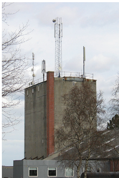
Mast/antenner placeret på bygning
