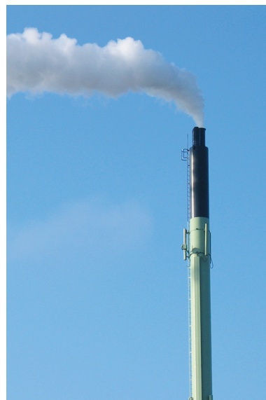
Antenner monteret på skorsten
