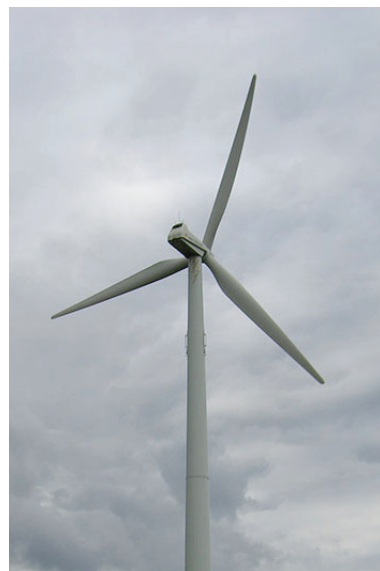
Antenner monteret på vindmølle
