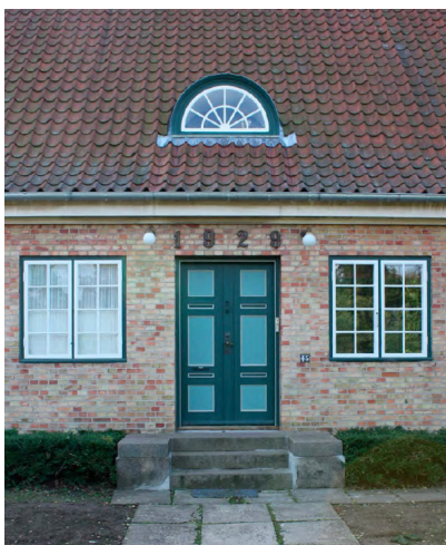
Eksempel på en inddelt facade med velproportionerede åbninger i facaden. Billede fra bevaringsguide for Bedre byggeskik.
