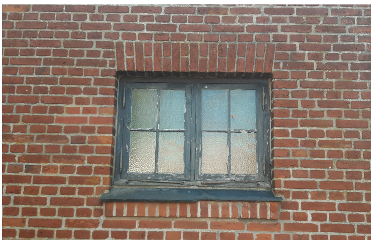
Småsproset vindue med vandret lige helstensstik
