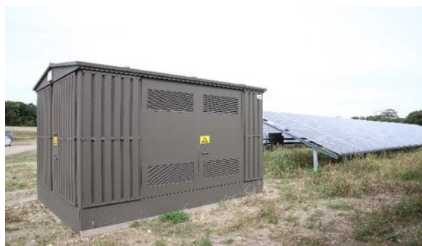
Figur 2.2: De hvide kasser under solcellerne er invertere, som omdanner jævnstrømmen til vekselstrøm (til venstre) og eksempel på teknikbygning, her en typisk fordelingstransformer (til højre).
