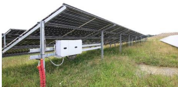
Figur 2.2: De hvide kasser under solcellerne er invertere, som omdanner jævnstrømmen til vekselstrøm (til venstre) og eksempel på teknikbygning, her en typisk fordelingstransformer (til højre).
