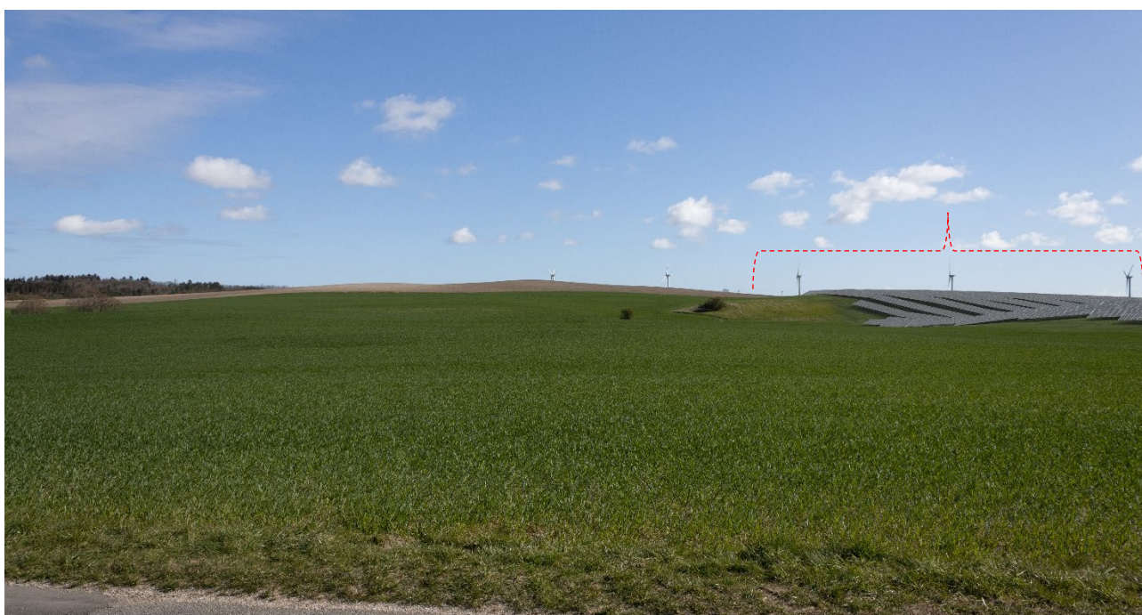
Figur 4-25 Visualiseringspunkt 4 – Visualisering af anlægget med faste øst-vestvendte paneler uden beplantning set fra Søbyvej ca. 250 m vest for delområde 1B.
