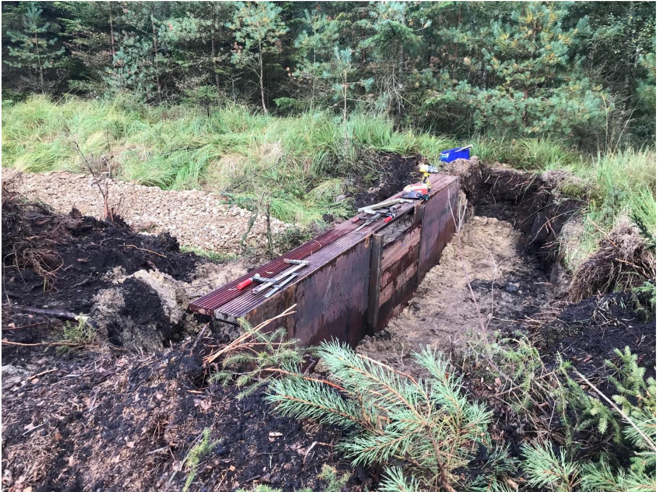
Figur 1. Et stem under etablering i Gjesing Mose
