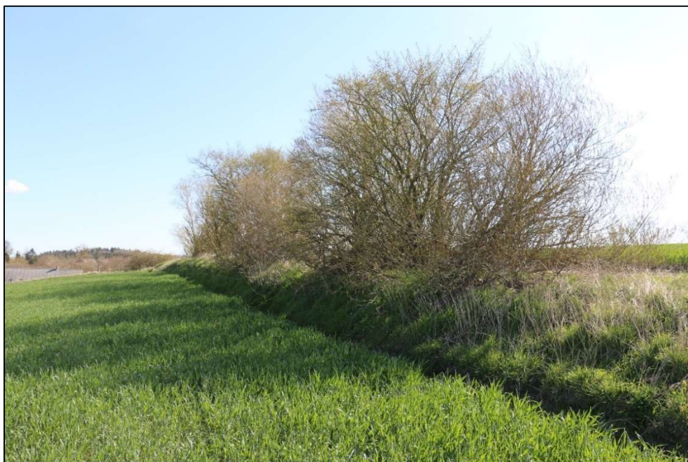
Figur 3-14 Foto fra COWIs besigtigelse, april 2021. Fotoet viser forhøjet terræn, som forekommer på størstedelen af diget.
