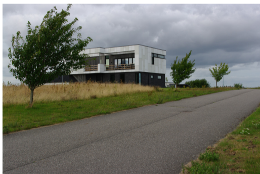
Nybygget villa i boligområdet mod syd.
