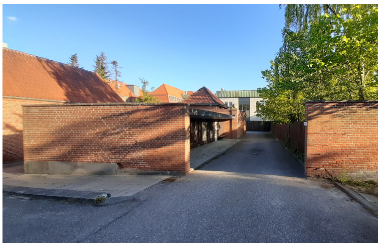
Tilbygning mod Nord, der har været brugt som redskabsrum, der nu er søgt nedrevet
