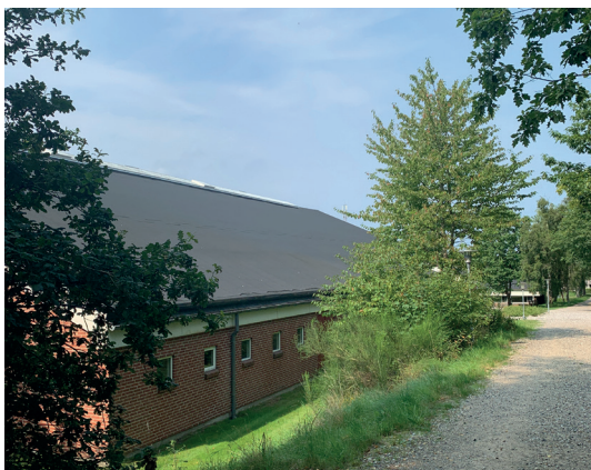
Idrætshal (bygning 10) og grusvej
