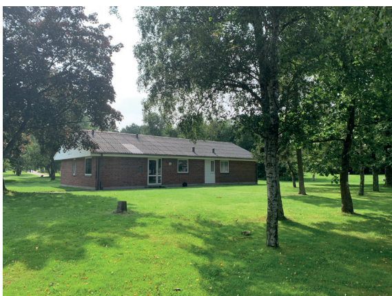
Elevboliger ud mod vejen (bygning 2)
