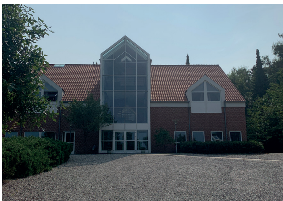
Administrationsbygning ved hallen (byggn. 11)
