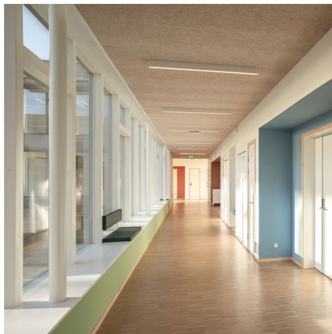
Lofter i gange som troldekt med plader i gangens fulde bredde uden fas eller spor - Hornbækhave, JJW Arkitekter
