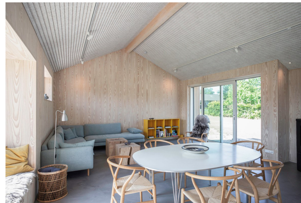
Lofter på de skrå flader i fællesarealer og café/aktivitet som troldekt med spor
