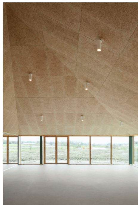
Lofter på de skrå flader i fællesarealer og café/aktivitet som troldekt Billede til venstre: Kræftrådgivningen Skejby, Claus Pryds Arkitekter Billede til højre: Hornbækhave, JJW Arkitekter
