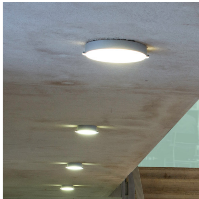
Påbygget armatur i gangarealer som Cubo Owen - findes i tre størrelser: Ø320, 260 og 130 mm
