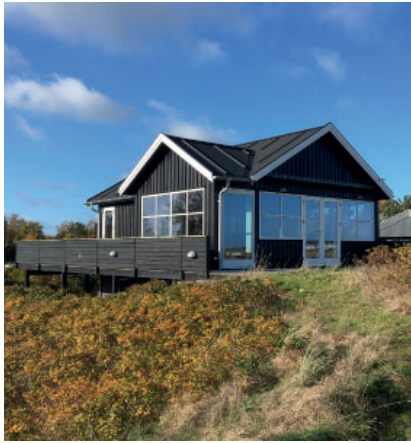
Eksisterende sommerhus placeret på klitkronen
