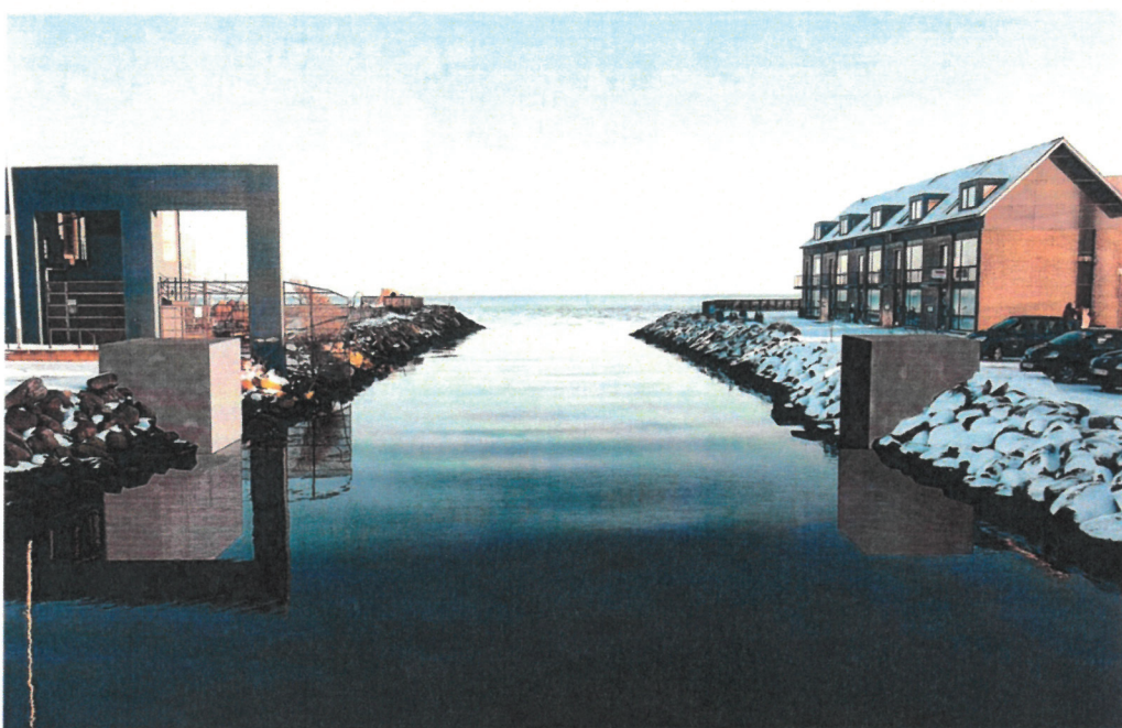
Fig. 2: Højvandeslusen er åben
