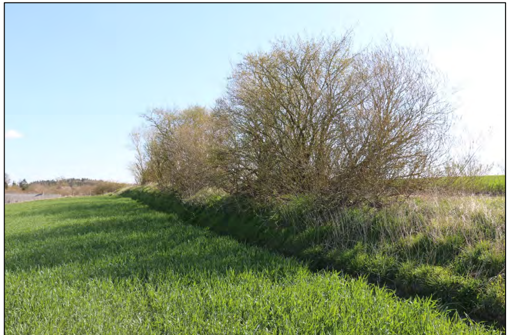
Figur 3-16 Foto fra COWIs besigtigelse, april 2021. Fotoet viser forhøjet terræn, som forekommer på størstedelen af diget.
