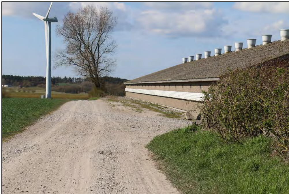
Figur 3-17 Foto fra COWIs besigtigelse, april 2021. Fotoet viser strækningen langs med ejendommen, hvor diget er jævnet. For enden af ejendommen ses det store træ som er omtalt i teksten ovenfor.
