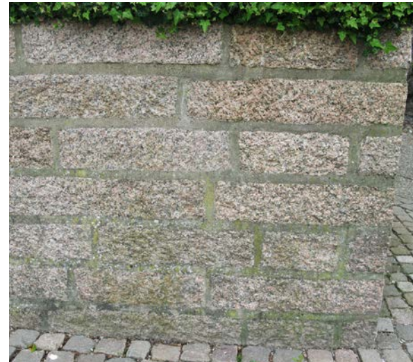
Eksisterende granitmur mellem kirken og rådhuset
