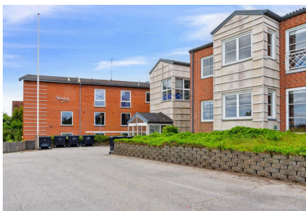
Foto 3: Bygninger set fra Auningvej.
