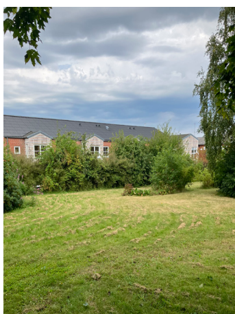
Foto 10: Beplantning foran bygning 3.
