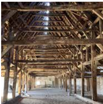
3. Bindingsværk - søjle/bjælke konstruktion
