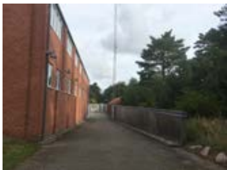
Nedkørsel til bebyggelsens lavere liggende gårdrum.
