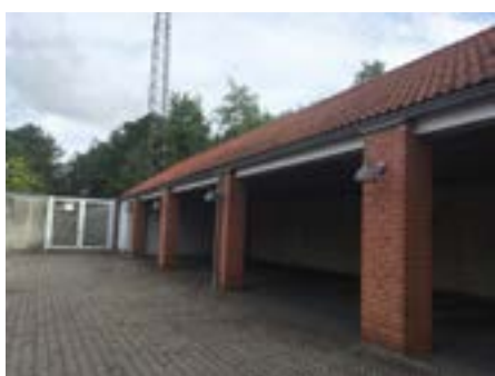
Garageanlæg i gårdrum.
