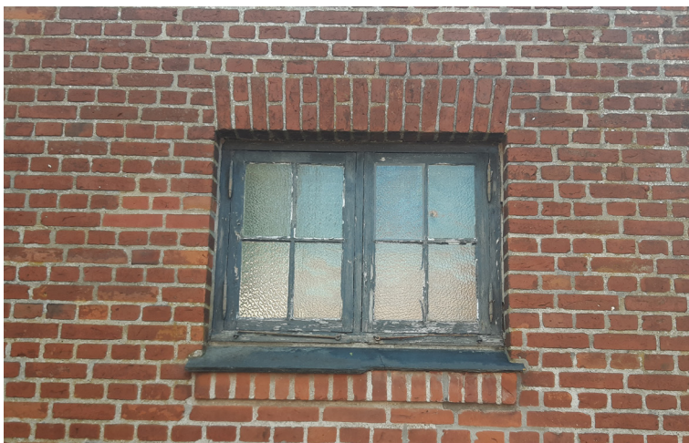
Småsproset vindue med vandret lige helstensstik
