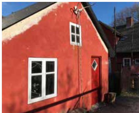
Udhuset, der ønskes anvendt til bryggeri, har en højde på ca. 4,5 meter.
