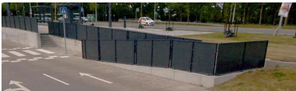
Rampe med 2 løb og repos
