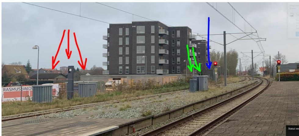
Figur 5 - Eksisterende skabe m.m. på Grenaa station
