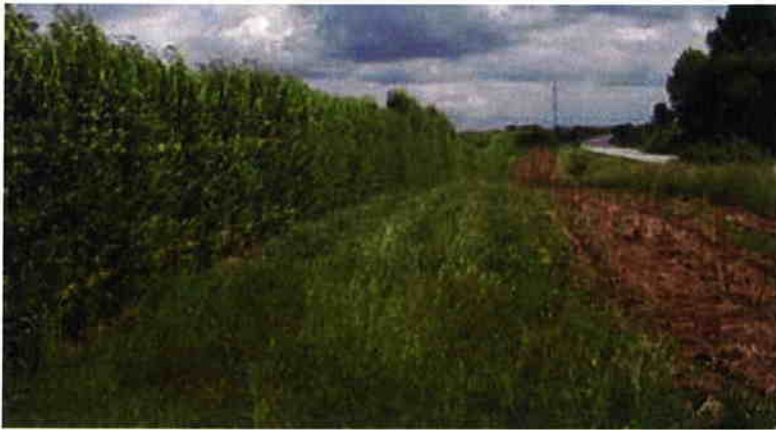
Støjskærm udført af pilehegn med lydisolering
