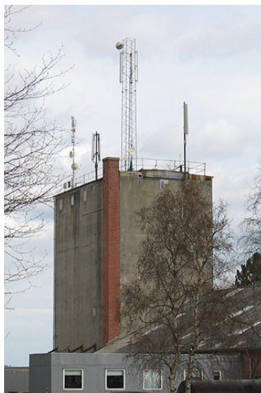
Mast/antenner placeret på bygning
