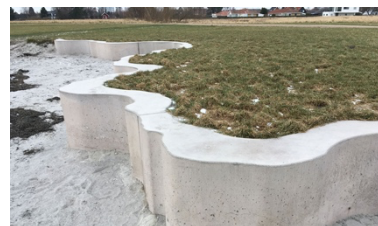
Reference 26 - Støbt kystsikring
