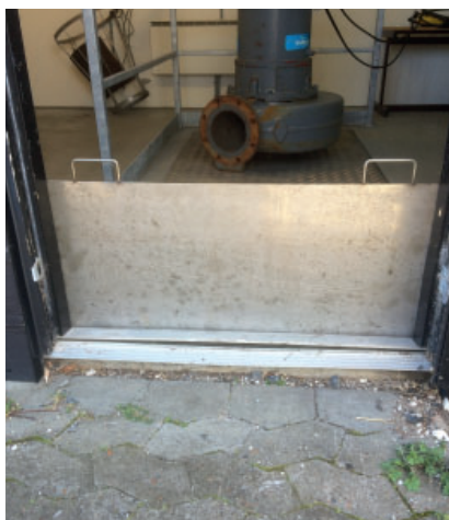
Eksempel på højvandsikring af indgangsdør.
