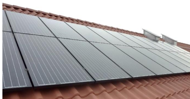
Solceller monteret på teglstenstag
