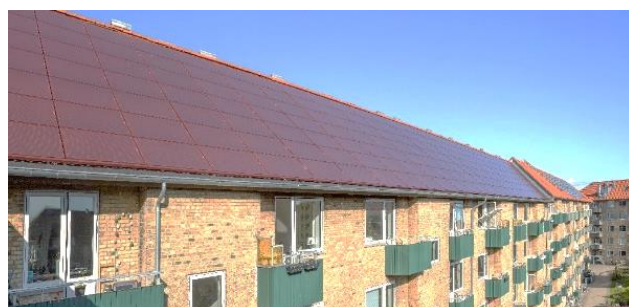
Bygningsintegrerede solceller Landsdommergården
