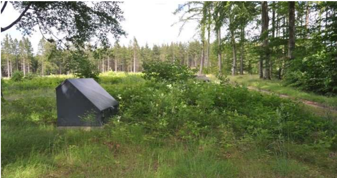
Figur 4.2 Borehus for indvindingsboring 70.991. De andre indvindingsboringer er etableret med tilsvarende borehuse.
