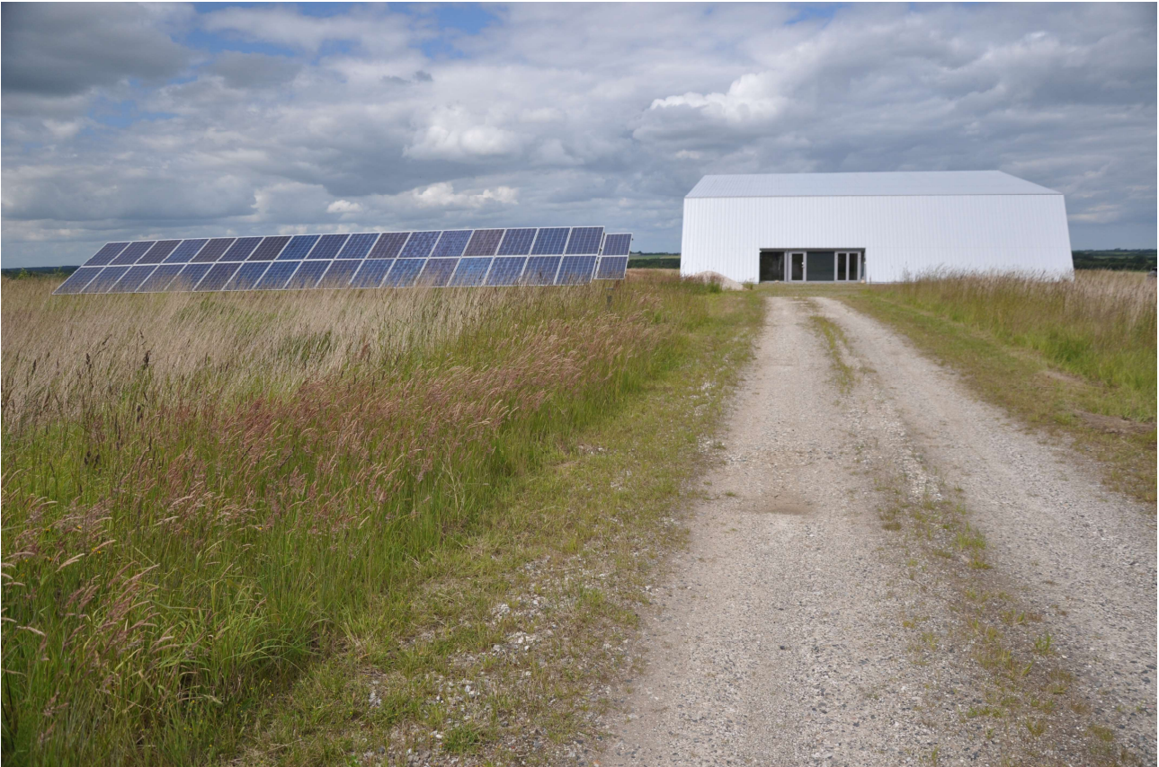
Figur 2.3 Det eksisterende vandværk på Gjesingvej med tilhørende solceller. Omkring vandværksgrunden findes en mindre beplantning.
