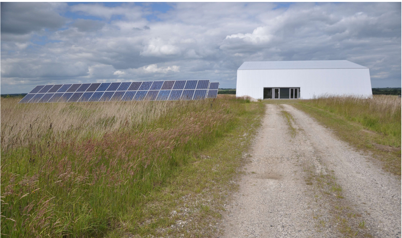
Figur 9.7 Vandværket vil blive udvidet ca. 15 m mod vest. Billedet er taget syd for bygningen, orienteret mod nord.
