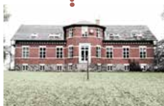
D, Hovedbygning (opr. stuehus)
