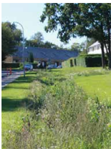
Eksempel på grøfter langs veje til håndtering af overfladevand
