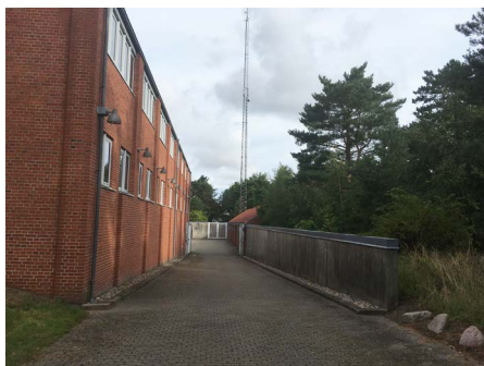
Nedkørsel til bebyggelsens lavere liggende gårdrum.
