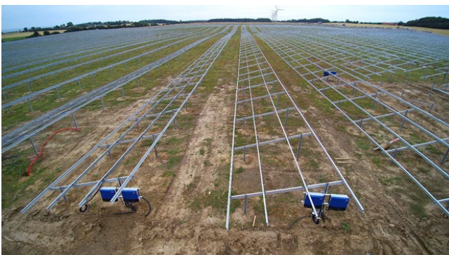
Aluminiumsstativer påsat invertere (blå)
