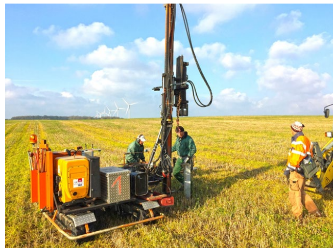
Eksempel på ramning af stativer
