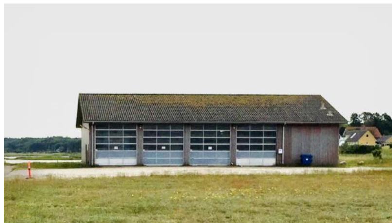
Busgaragens eksisterende facade mod vest. (P areal)
