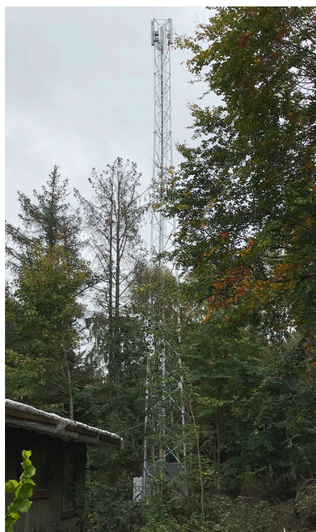
Masten set fra Kærvejen 5 umiddelbart nordvest for denne lokalplans område.
