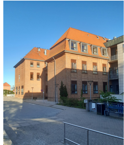
Nogle af de andre oprindelige bygninger fra sygehuskomplekset, uden for lokalplanområdet
