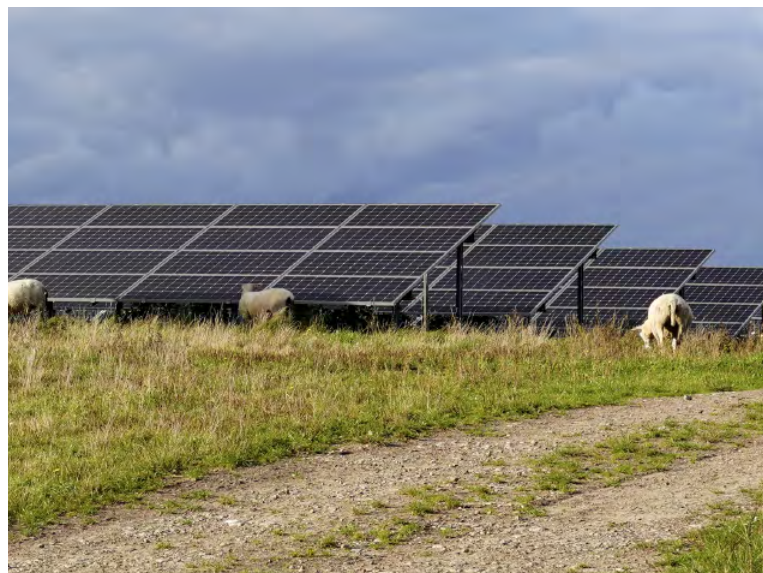
Figur 2. Eksempel på solceller monteret på faste stativer.
