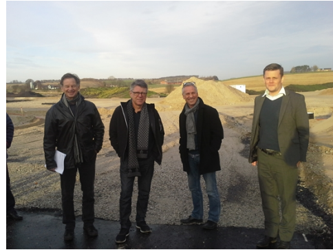
Miljø- og Teknikudvalget Mads Nikolajsen, Næstformand Niels Basballe, Niels Ole Birk og formand Jens Meilvang (udvalgets 5. medlem Tom Bytoft fraværende) besigtiger anlægsarbejdet 22. november 2016 ved den "første køretur på omfartsvejen"
