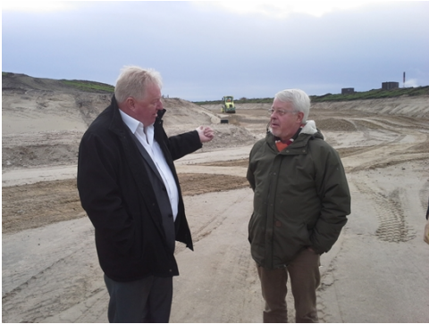
Næstformand i Folketingets Transportudvalg Kim Christiansen og borgmester Jan Petersen besigtiger anlægsarbejdet 3. november 2016
