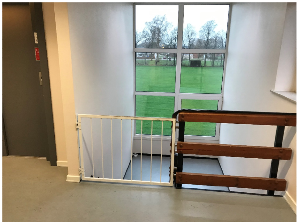
Figur 5 Billede af låge foran trappe bygning 2
