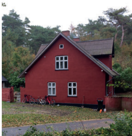
Hovedhuset har en højde på ca. 7,4 meter.
