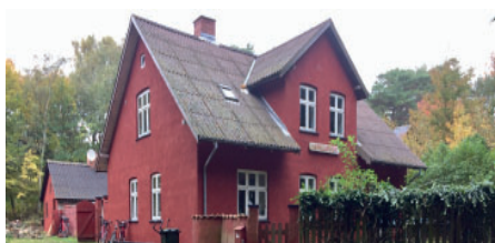
Hovedhuset med den karakteristiske frontispice, er tildelt bevaringsværdi 4.
