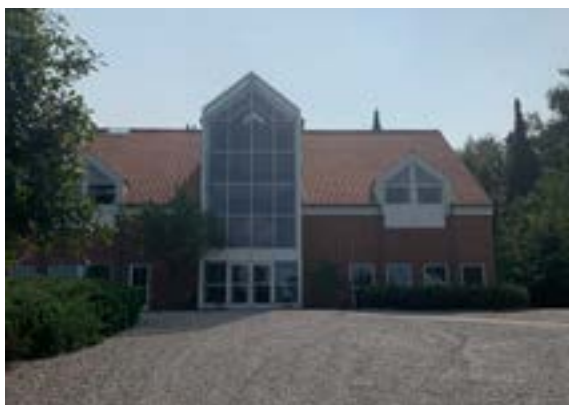
Administrationsbygning ved hallen (byggn. 11)
