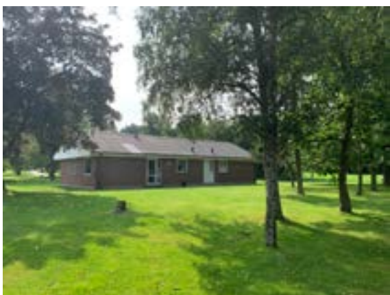
Elevboliger ud mod vejen (bygning 2)
