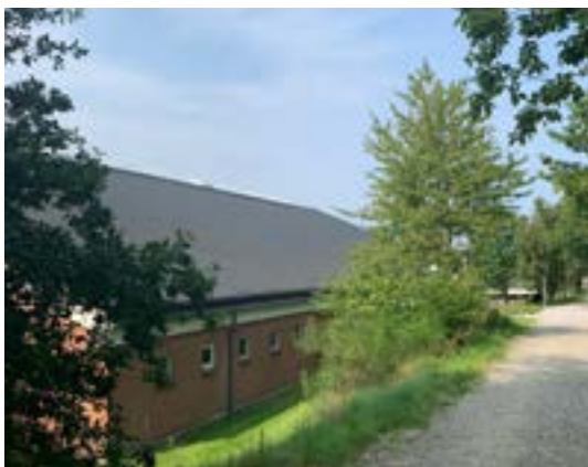
Idrætshal (bygning 10) og grusvej
