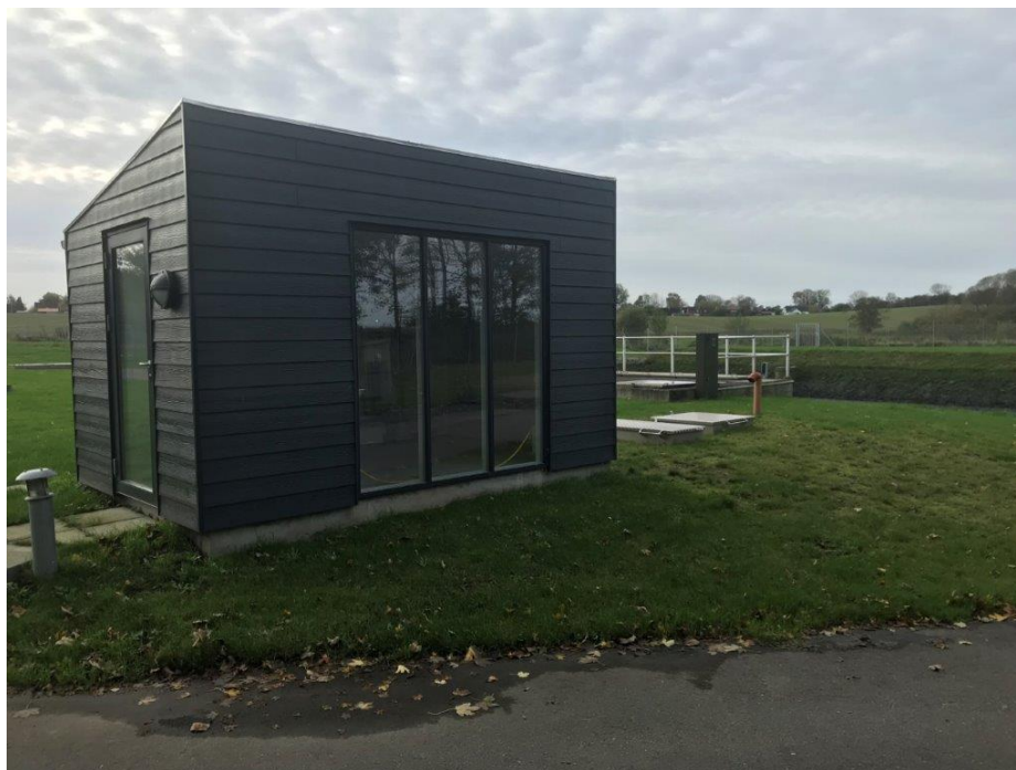
Figur 2-6: Eksempel på en pumpebygning.
