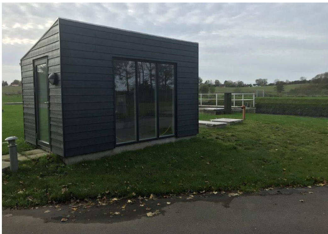
Figur 7-10: Eksempel på en pumpebygning.
