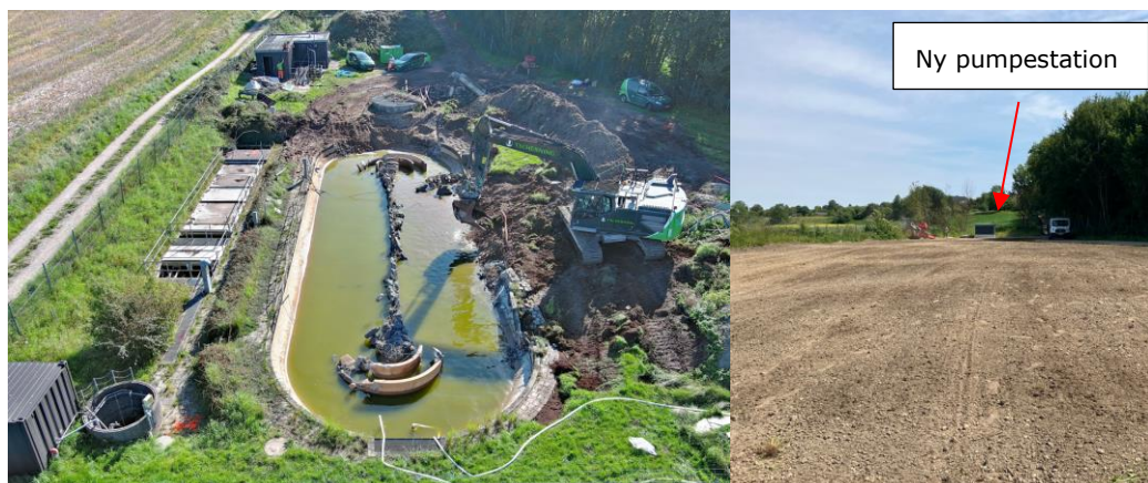
Figur 2-9: Eksempel på nedrivning og resultat.
