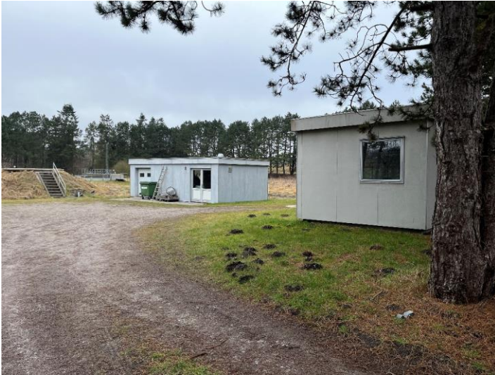
Figur 5-8: Bygningerne på Tåstrup-Feldballe Renseanlæg.
