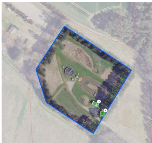
Figur 5-3: Tåstrup-Feldballe Renseanlæg. Bygningerne, der nedrives, er markeret med 1 og 2.
