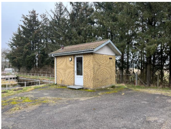
Figur 5-4: Nordlige bygning, Thorsager Renseanlæg.
