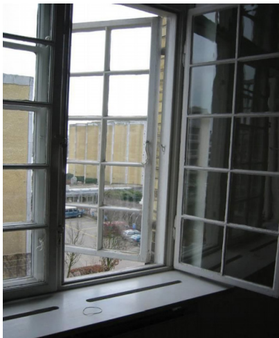
Eksempel på en koblet ramme, fra bygningsbevaring.dk
