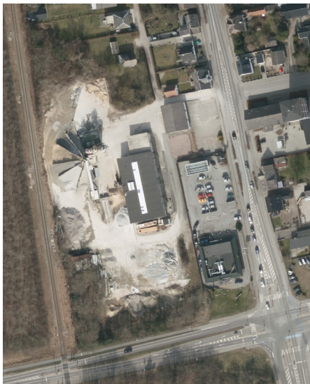
Ortofoto fra 2018 viser cementvarefabrikken lige før den blev nedrevet.
