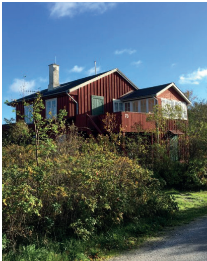
Eksisterende sommerhus med en veltilpasset tilbygning.
