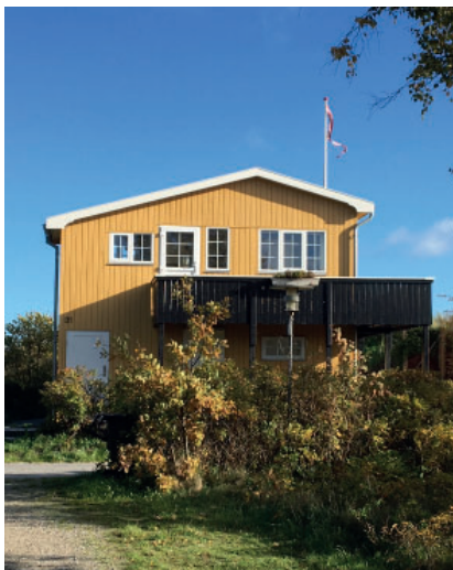
Eksisterende ældre sommerhus
