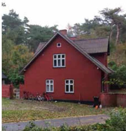
Hovedhuset har en højde på ca. 7,4 meter.
