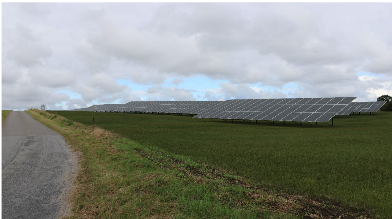
Figur 4-35 Visualiseringspunkt 7 – Visualisering af anlægget uden beplantning set fra Andkærvej syd for delområde 2. Solcellerne etableres med en højde på ca. 3 meter over terræn.
