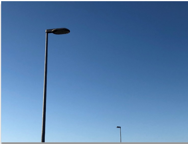
Figur 8 - Armaturer på Skolegade, Allingåbro
