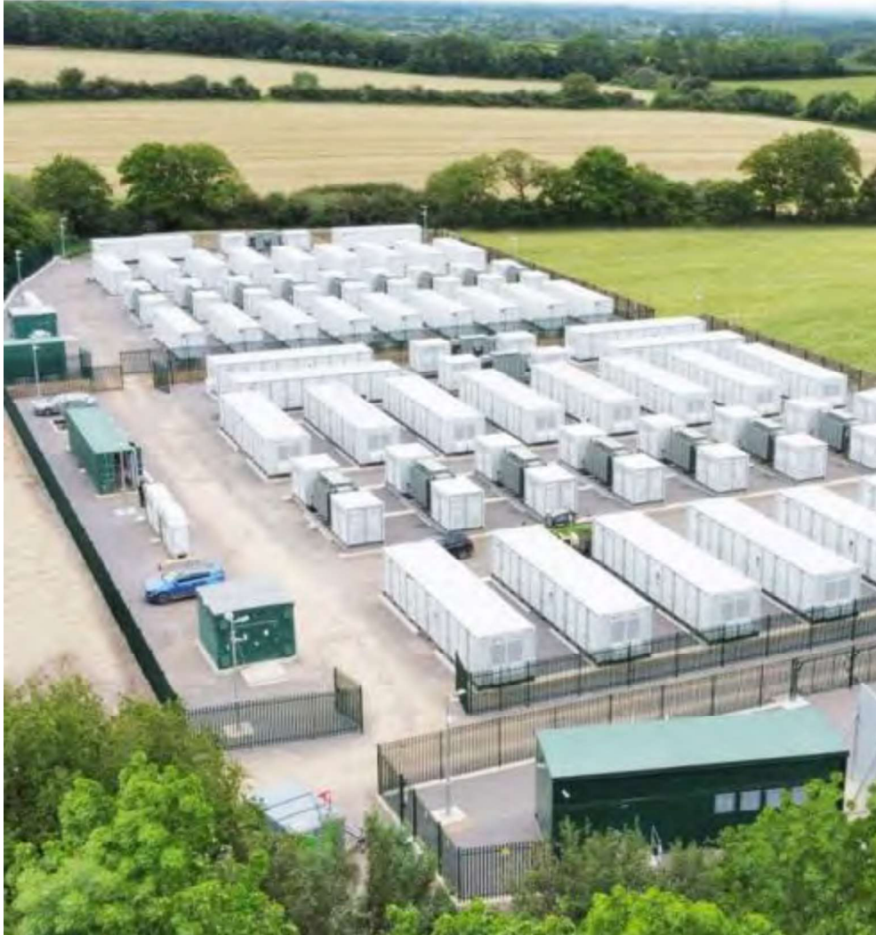
BESS-anlæg – Modulopbygning med 20-fods containere og invertere.
