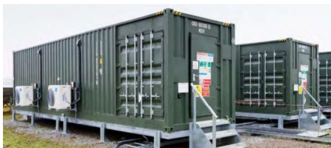
Billede 6: Eksempler på hhv. 20- og 40-fods container batterianlæg.
